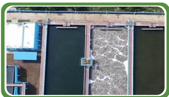
33 MLD STP, Anand, Gujarat
