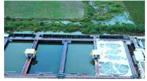
32.3 MLD STP, Surendra Nagar, Gujarat
